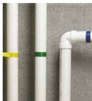
工場配管の識別
